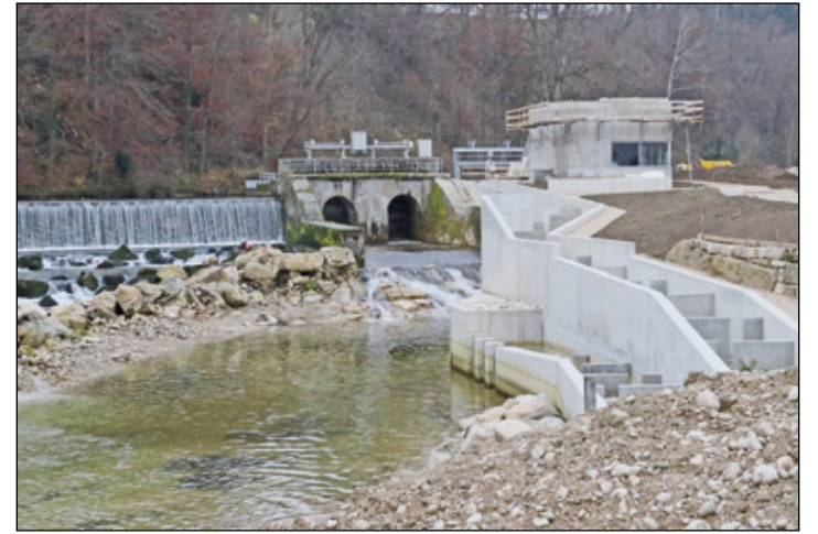
La passe à poissons à droite et au second plan la centrale. (ALAIN PRÊTRE)
